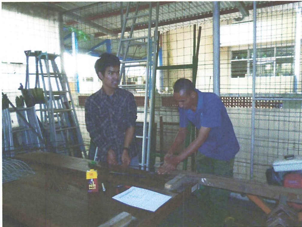
Foto : Pemotongan Tulangan Longitudinal
