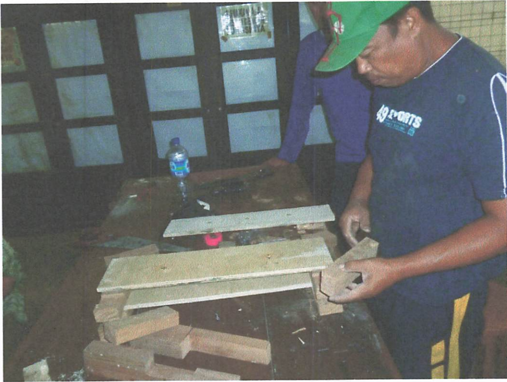
Foto : Perakitan Bekisting Kolom
