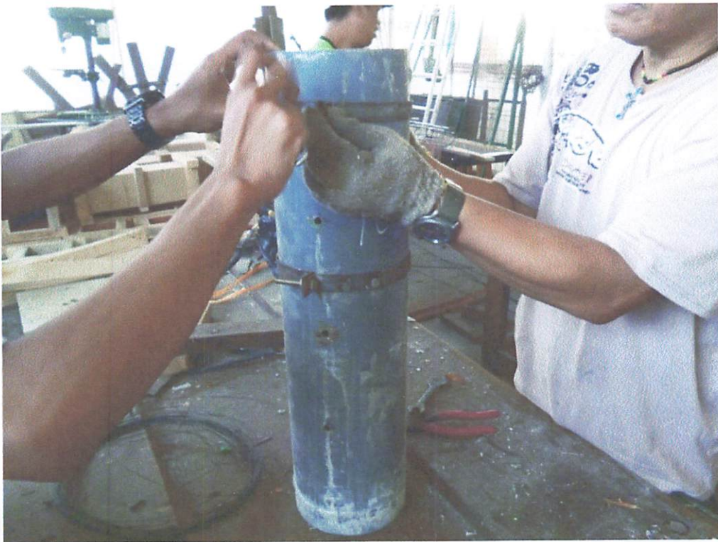
Foto : Perakitan Bekisting Kolom
