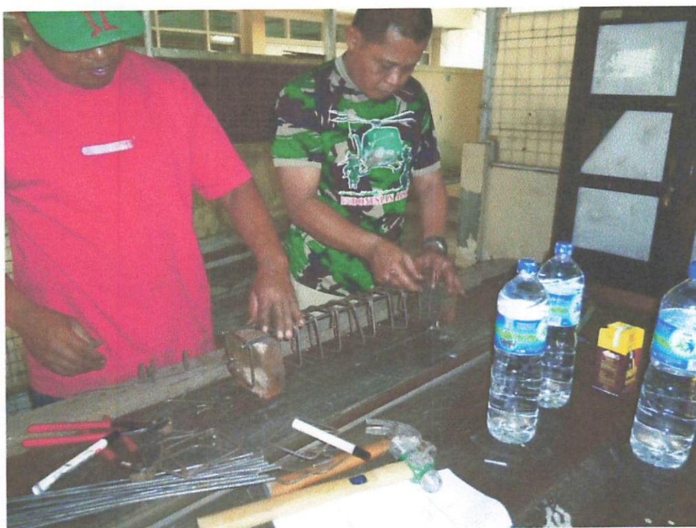
Foto : Perakitan Tulangan Kolom
