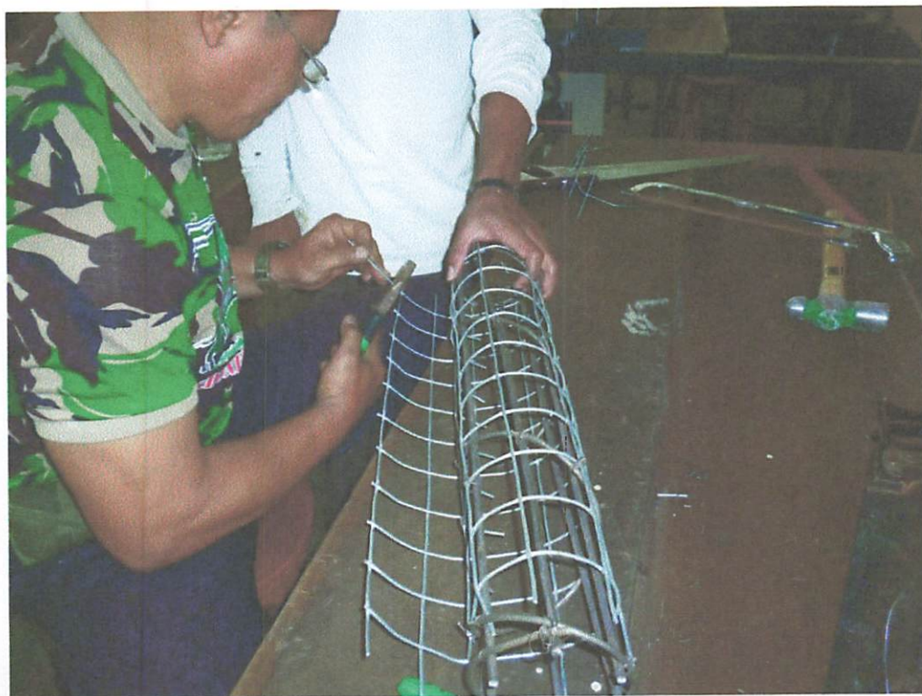
Foto : Pemasangan Fine Mesh Pada Tulangan Kolom
