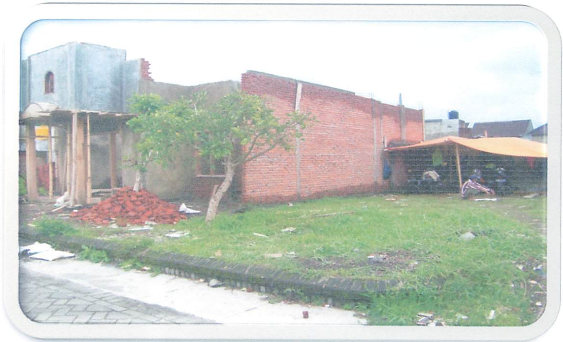
Tgl September 2011 Lokasi studi Perumahan Puri Permata / Tulungagung Kegiatan : Pelapisan dinding bangunan dan tempat istirahat para pekerja (tukang batu)
