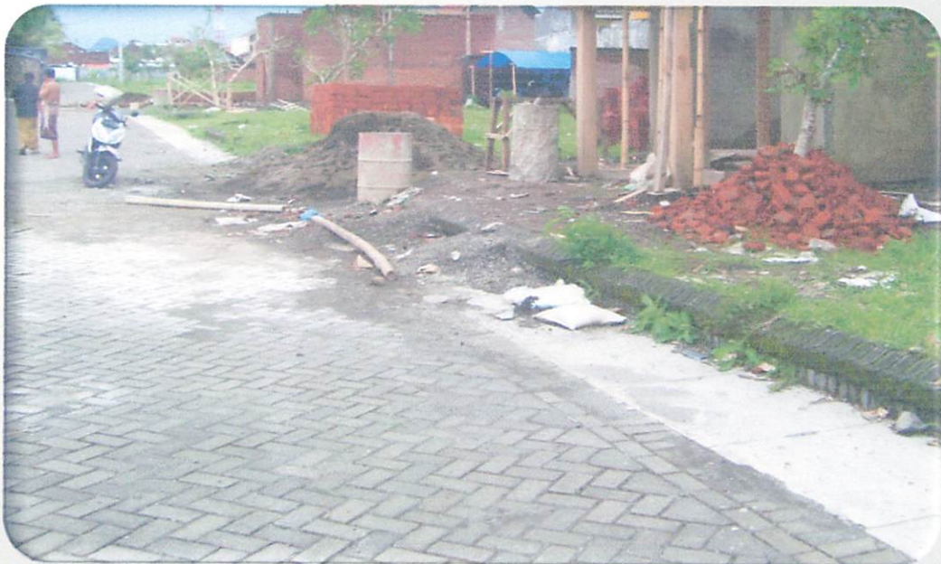
Tgl September 2011 Lokasi studi Perumahan Rimba Karya / Tulungagung Kegiatan : Tahapan Pemasangan Paving jalan Perumahan
