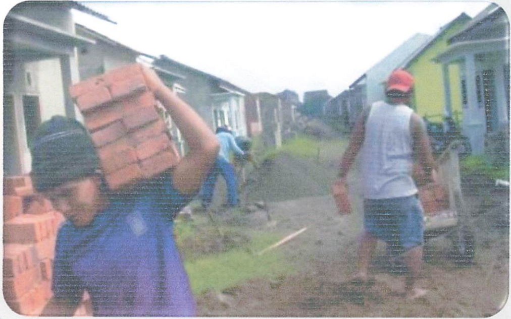
Tgl September 2011 Lokasi studi Perumahan Rimba Karya / Tulungagung Kegiatan : Persiapan bahan bangunan (Bata merah)
