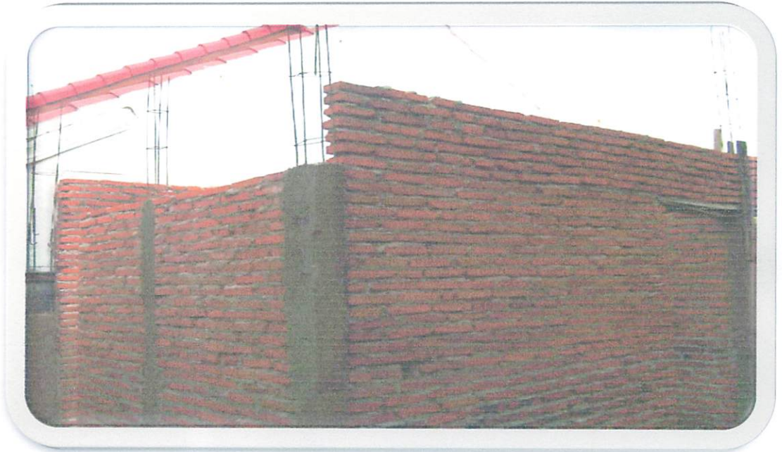
Tgl September 2011 Lokasi studi Perumahan Puri Permata / Tulungagung Kegiatan : Pembangunan dinding perumahan menggunakan Bata merah
