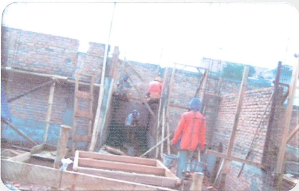
Tgl September 2011 Lokasi studi Perumahan Rimba Karya / Tulungagung Kegiatan : Tahapan Pembangunan Dinding bangunan
