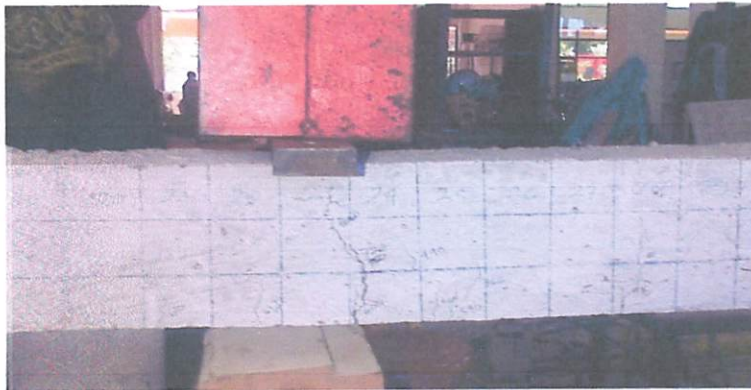
Gambar 4.7. Pola retak balok tanpa sambungan (BTS)-B
