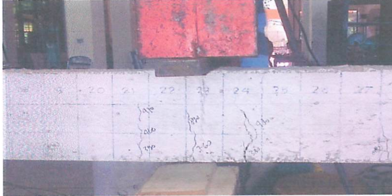
Gambar 4.8. Pola retak balok tanpa sambungan (BTS)-C
