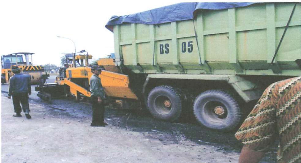
Penuangan Material CTB Dari Damp Truck ke Asphalt Finisher
