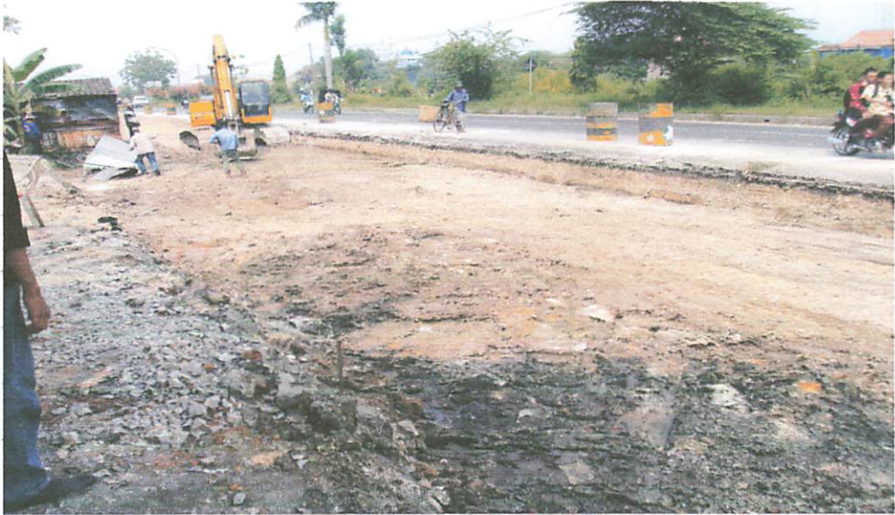
Pekerjaan penggalian dan pelebaran pada area proyek dengan Eksavator
