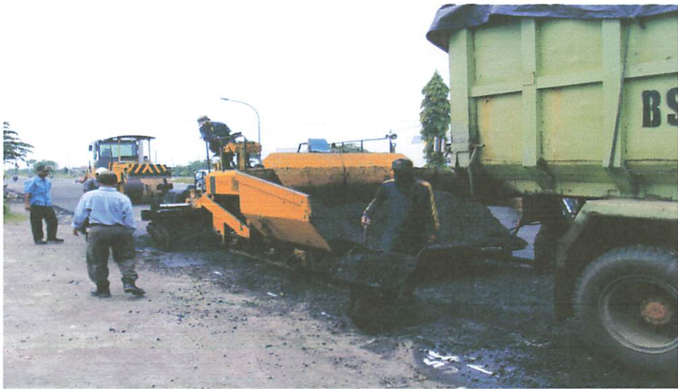
Penuangan Material CTB Dari Damp Truck ke Asphalt Finisher
