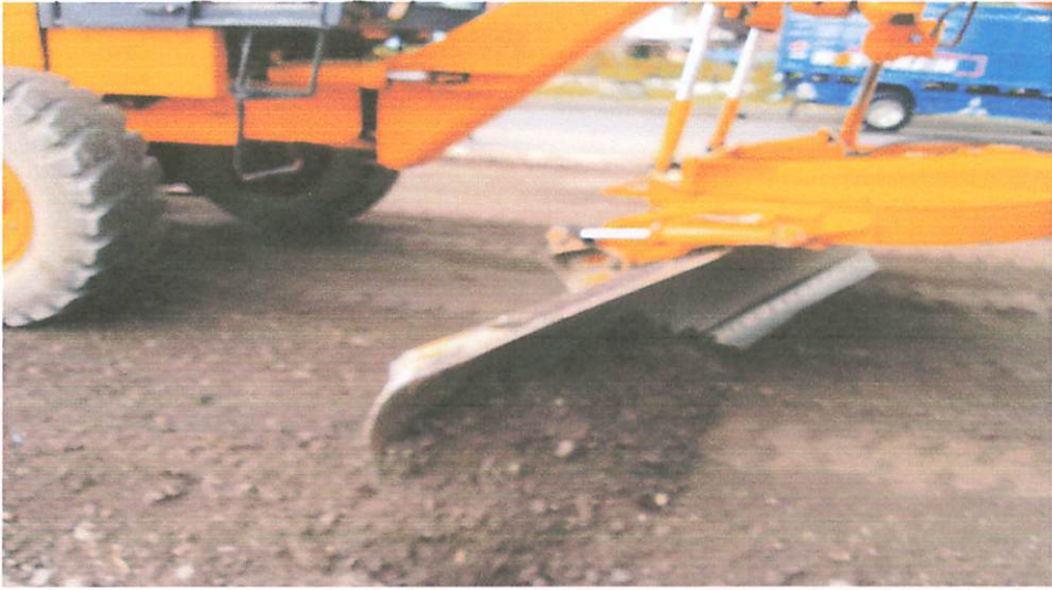
Gambar Wheel Loader sedang meratakan pembangunan jalan
