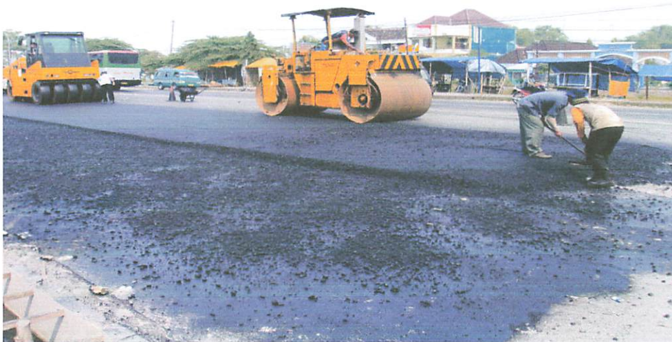
Pemadatan dengan Tandem Roller dan Pneumatic Tire Roller
