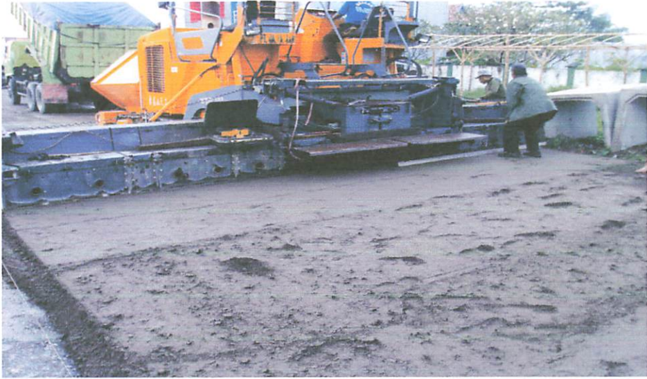
Gambar Asphalt Finisher sedang meratakan material CTB
