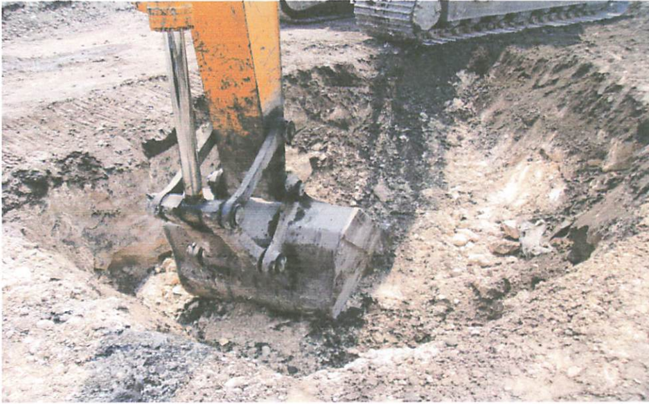
Gambar Eksavator sedang bekerja di area proyek
