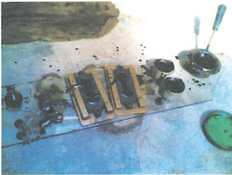
Penuangan aspal ke cetakan
