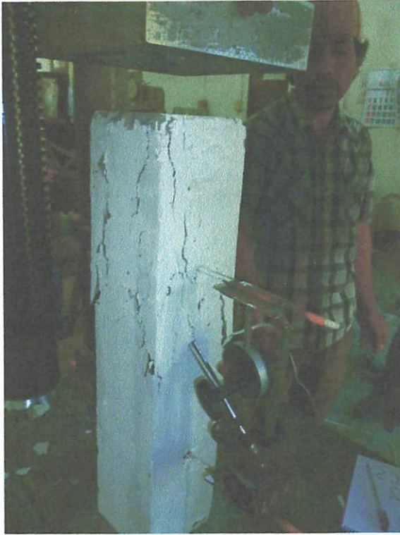
Gambar 4.4a Spalling Pada kolom RCFM_1 P = 35 ton dan \epsilon'_c = 0,0024
