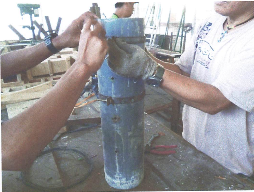
Foto : Perakitan Bekisting Kolom
