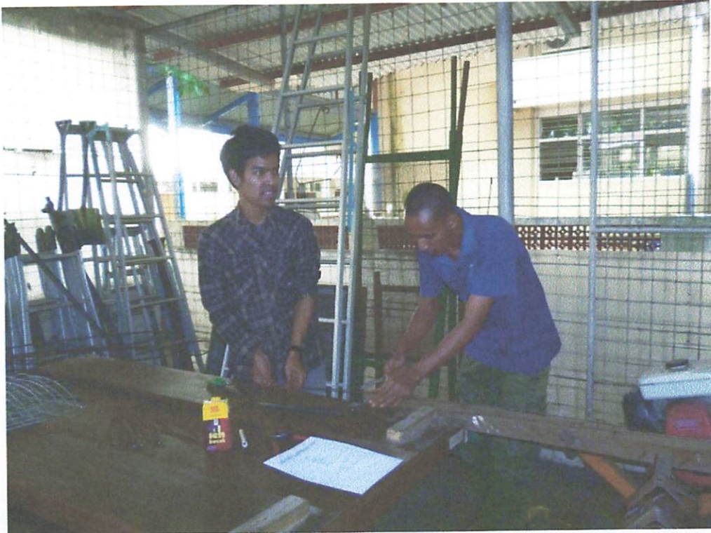
Foto : Pemotongan Tulangan Longitudinal
