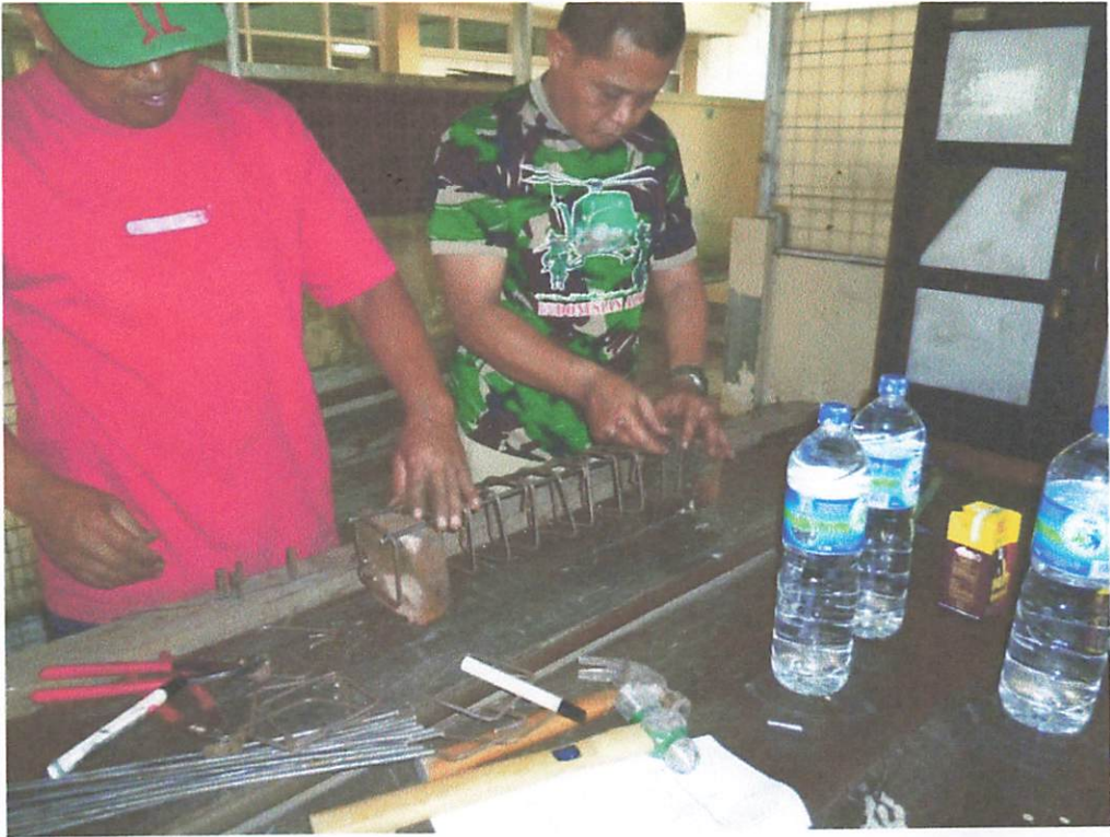
Foto : Perakitan Tulangan Kolom
