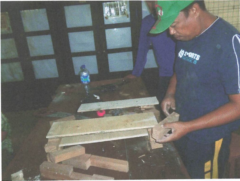
Foto : Perakitan Bekisting Kolom
