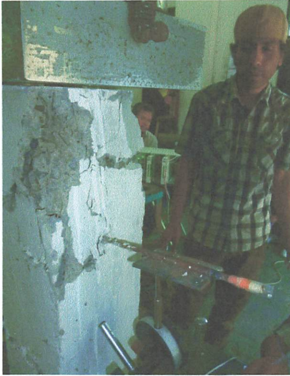
Gambar 4.2 Spalling Pada Kolom ( RCP ) saat P = 28,5 ton dan \varepsilon'_c = 0,00231
