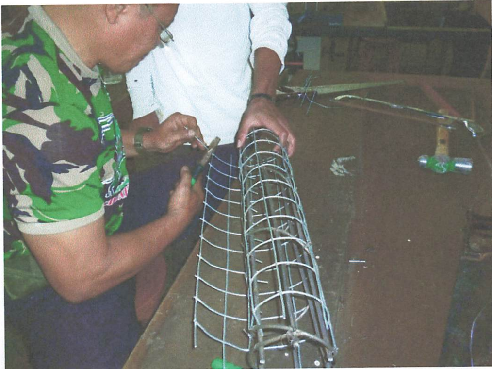
Foto : Pemasangan Fine Mesh Pada Tulangan Kolom
