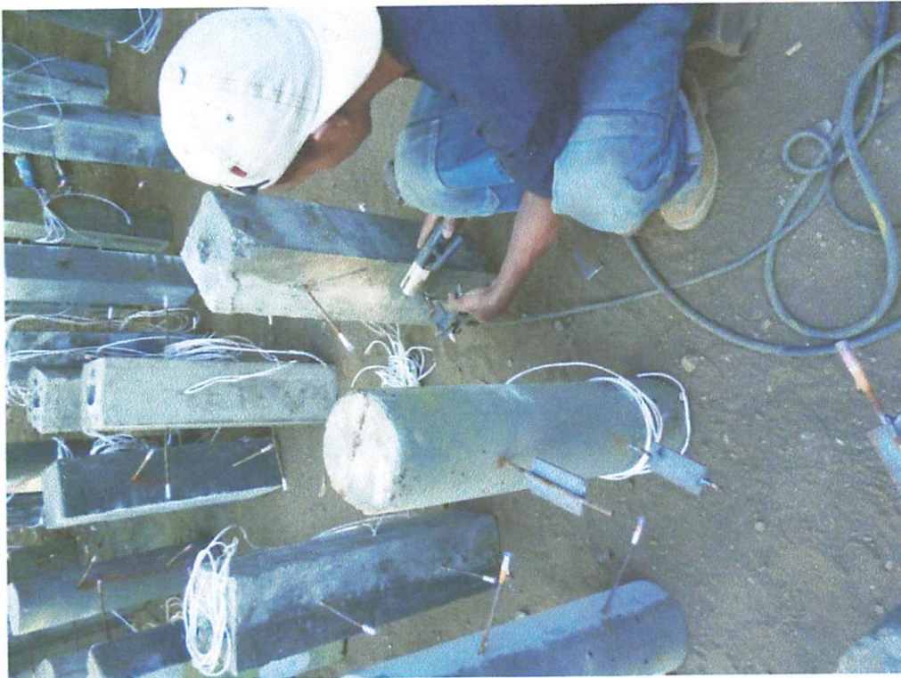
Foto : Pengelasan Plat Stripe Untuk Eldivity
