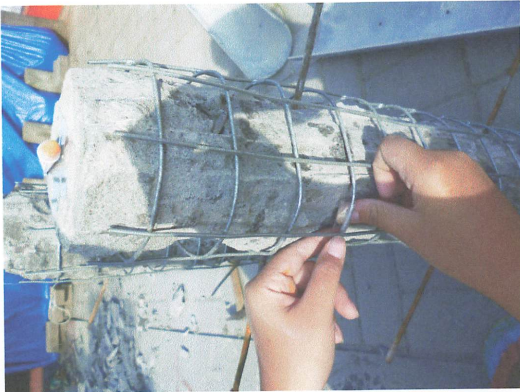
Foto : Pemasangan Fine Mesh Tahap II
