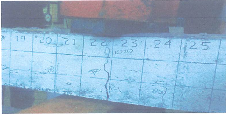
Gambar 4.6 Pola retak balok tanpa sambungan (BTS)-A
