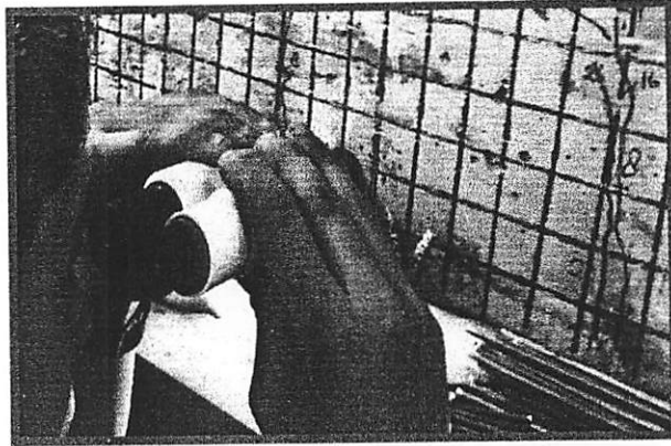
Gambar 4.34 Pengukuran lebar retak akhir
