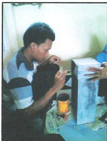
Foto 2.3 : Pemberian Epoxy pada permukaan kolom
