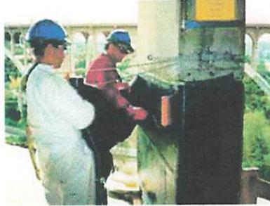
Gambar 2.2. Mengolesi Resin atau perekat (*epoxy*) pada permukaan kolom menggunakan Roller atau kuas silinder
