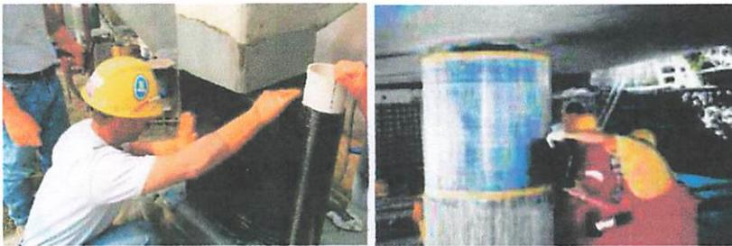
Gambar 2.3. Pemasangan *CFRP* pada daerah paling berbahaya yang sudah diolesi resin atau perekat (*epoxy*)
