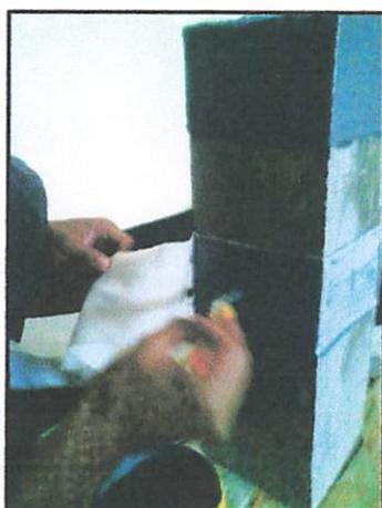
Foto 2.5 : Pemasangan CFRP
