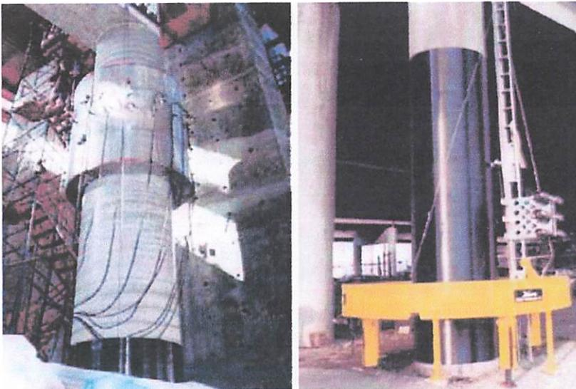
Gambar 2.4. Mesin alat pemasang *CFRP* kolom bulat
