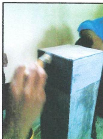
Foto 2.4: Pemberian Epoxy pada permukaan kolom
