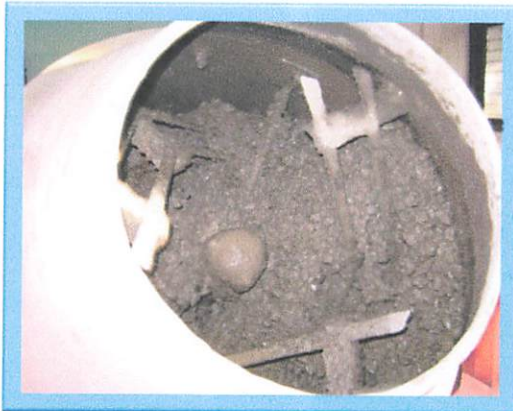
Foto1.1 :Pengadukan Beton Dengan Molen
