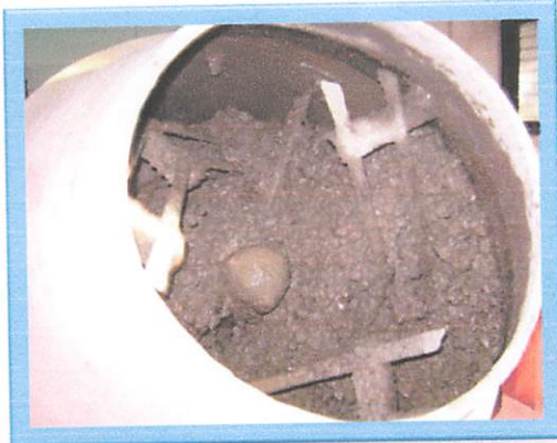
Foto Pengadukan Beton Dengan Molen
