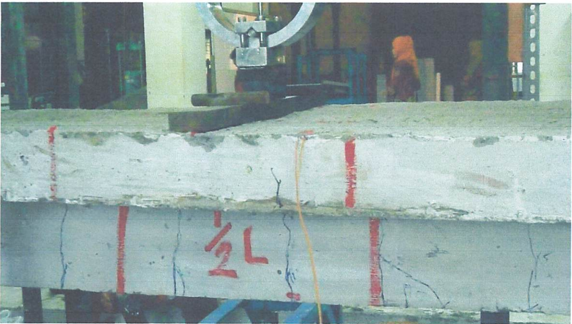
Foto 4.8 Retak balok T dengan jarak sambungan beton dan tulangan seper – dua bentang B
