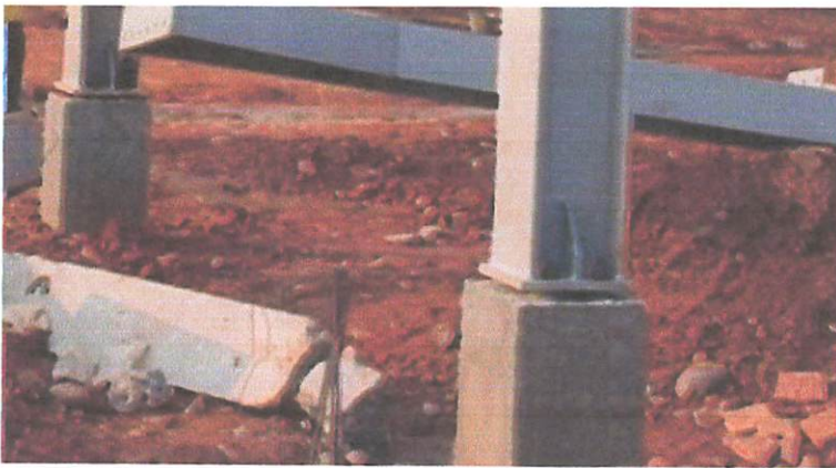
Gambar 4.5 Pemasangan Kolom
