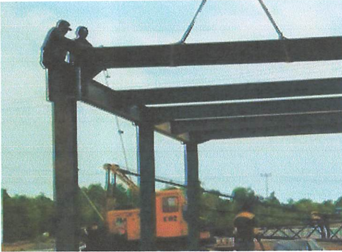
Gambar 4.6 Pemasangan Balok - Kolom
