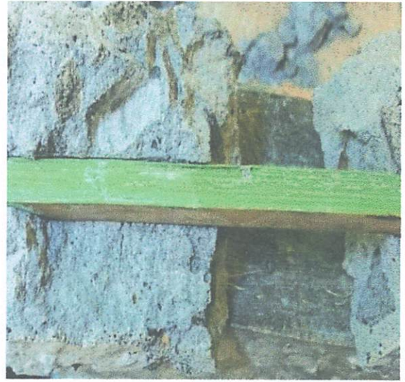
Gambar 5.3. bambu BC setelah beton mengering
