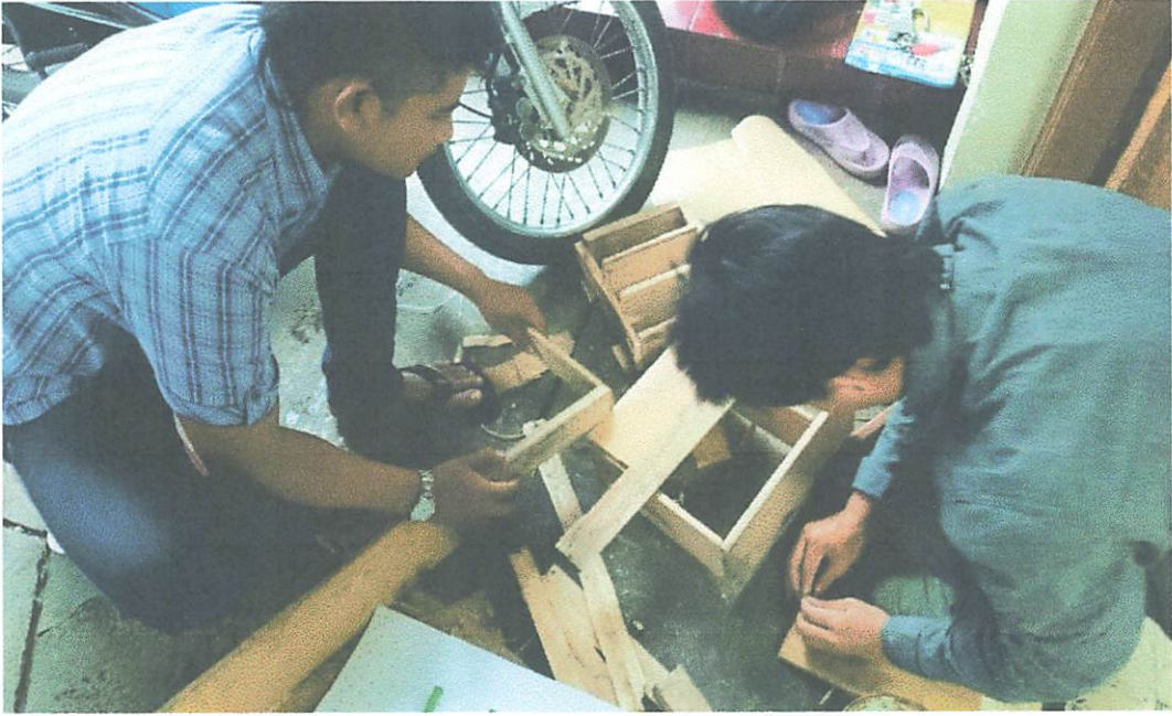
PEMBUATAN BEKISTING KUBUS
