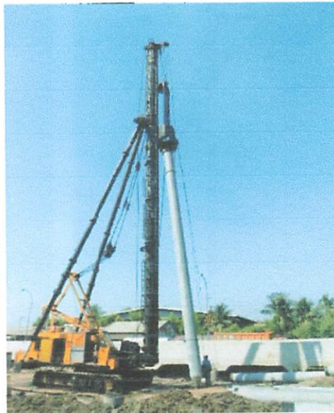
Gambar Pemancangan Tiang Pancang Ditarik dengan Sling
