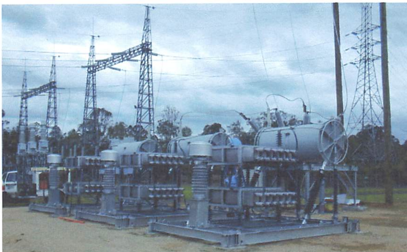
Gambar 2.8 Kapasitor Yang Dipasang Pada Gardu Induk
