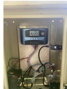
Gambar 4. 13 Tampilan Sistem pada panel Iradiasi & Temperatur
