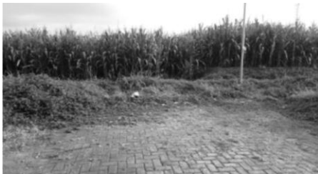
Gambar 1. Eksisting Tembok Pembatas
