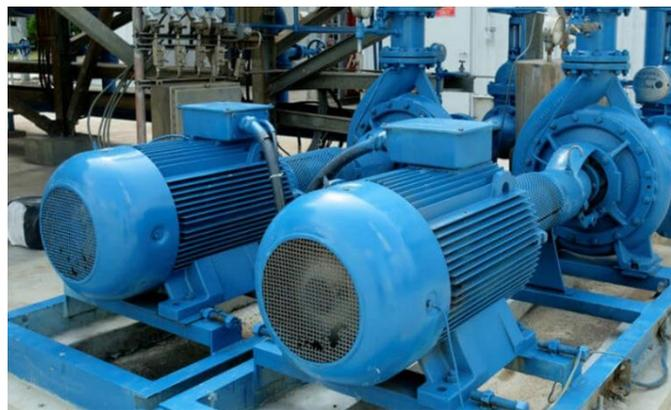
Gambar 1. 1 Alat berat Pompa Sentrifugal
