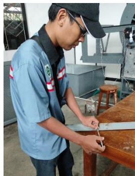
Gambar 3.29 Pemasangan Turbin Darrieus NACA 0015 pada poros penggerak, pulley, beserta generator
