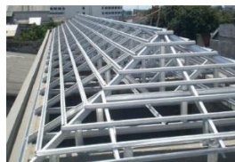
Gambar 14. Kerangka Atap Menggunakan Baja Ringan
