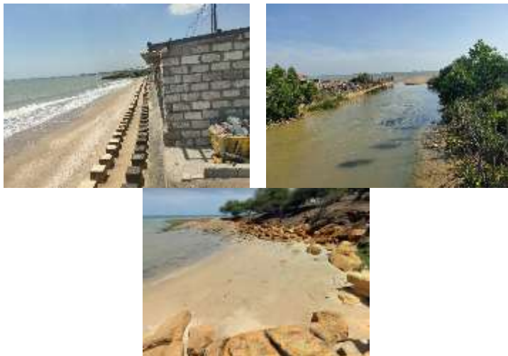
Gambar 4. 7 Kondisi Eksisting Wilayah Pesisir Kecamatan Bancar
