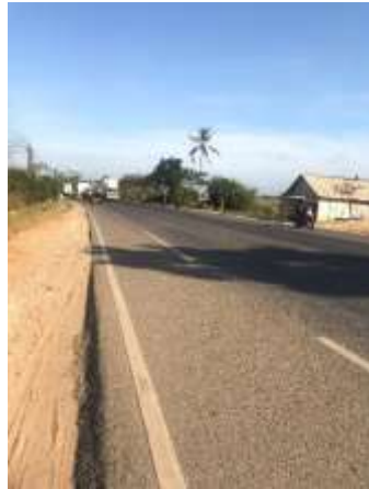
Jalan Raya Tuban-Senarang (Pantura)
