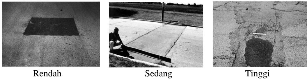
Gambar 2. 11 kerusakan jenis tambalan (Sumber: Indeks Kondisi Perkerasan, 2016)
