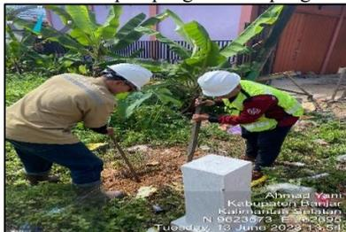
Gambar 3.5 Pemasangan Titik Kontrol
