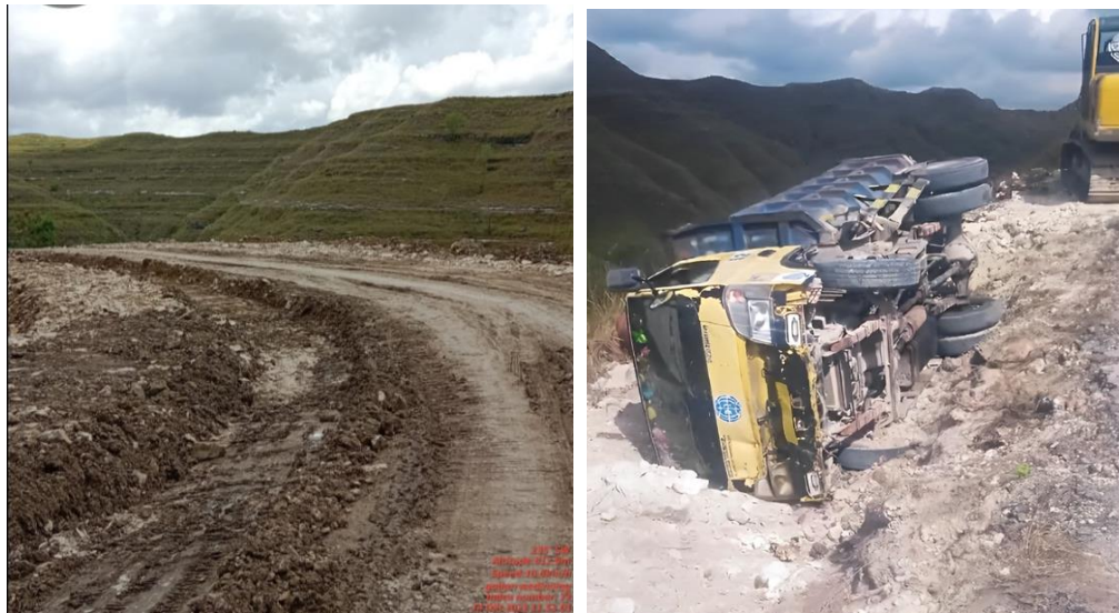
Gambar 1. 1 Contoh kerusakan dan akibat kerusakan ruas jalan Kawangu-Tanarara
