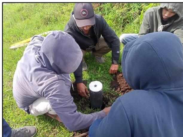
Gambar 3. 3 Pemasangan patok *ICP*
