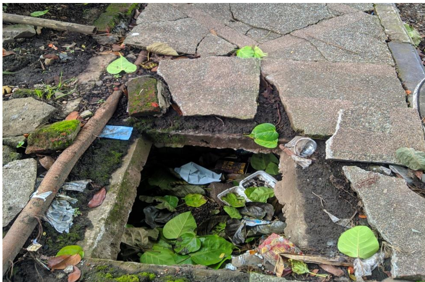
Gambar 1.2 Gambar saluran drainase yang bermasalah pada jl. Ahmad yani, , kecamatan kepanjen
