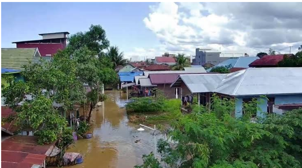
Gambar 1.1 Kondisi Banjir di Lokasi Studi
