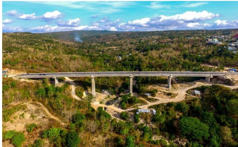
Gambar 1.1 Kondisi Eksisting Jembatan Petuk 1
