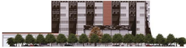
Tampak Depan bangunan
