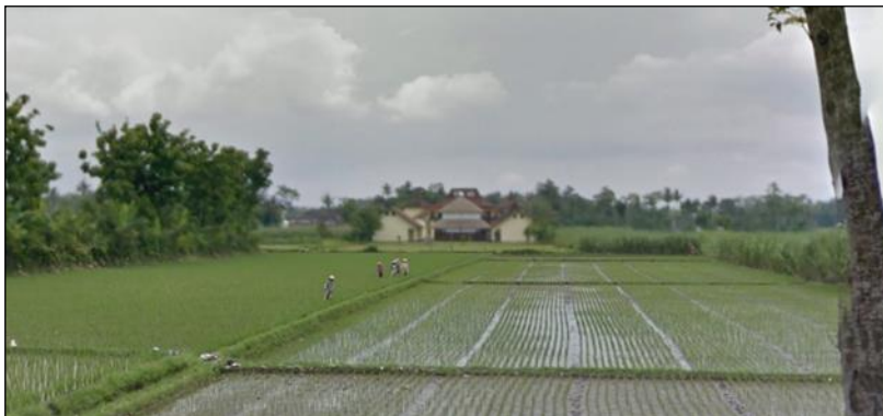
Gambar 3. Kondisi eksisting bangunan sekolah dilihat dari arah jalan raya
