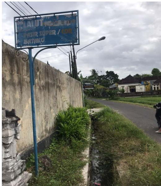
Gambar Saluran Eksisting Jl Nusa Indah I Kiri
