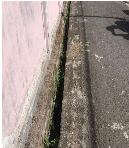
Gambar Saluran Eksisting Nusa Indah I Kiri
