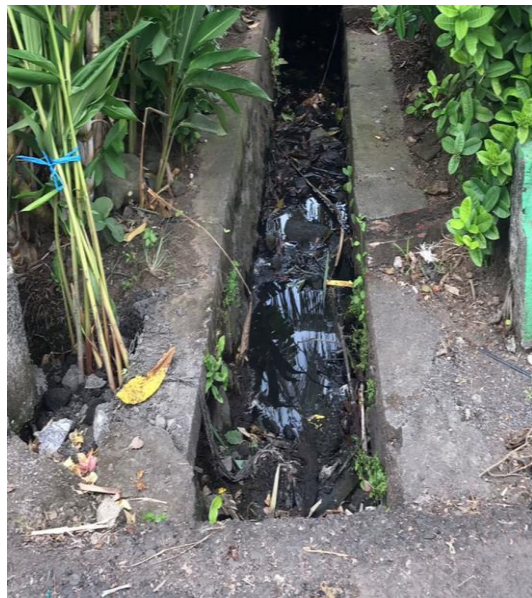
Gambar Saluran Eksisting Jl. Nusa Indah V Kiri
