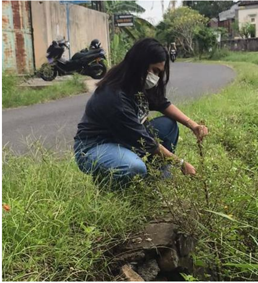
Gambar Pengukuran Dimensi saluran eksisting Jl. Cempaka Kanan
