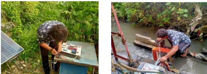
Gambar 24. Proses Pemasangan Pembangkit Hybrid
