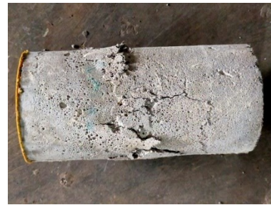
Gambar 4. 1 Pola Retak Pada Silinder Beton Ringan
