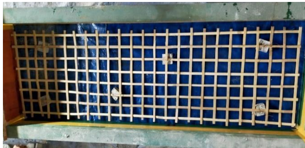
Gambar 3. 4 Pemasangan Penulangan dan Beton Decking
