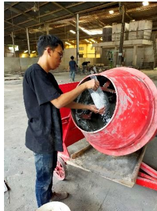
Gambar 3. 5 Pencampuran Beton dan Penambahan Styrofoam
