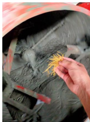
Gambar 3. 6 Pencampuran Beton dan Penambahan Serat Bambu
