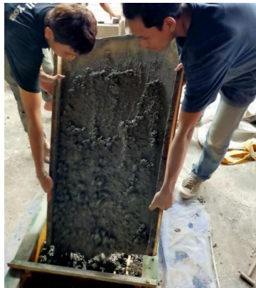
Gambar 3. 7 Proses Cetakan Campuran Beton
