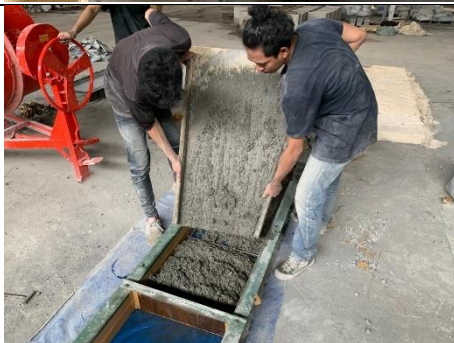
Pelaksanaan Pengecoran Pelat Beton
