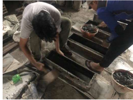
Proses pepadatan campuran beton
