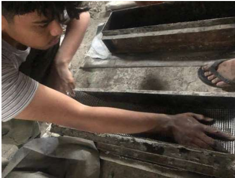
Proses pemasangan fiberglass
