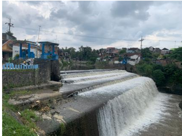
Gambar 1.1 Bangunan Dam Kadalpang Malang dengan pelimpah Bertangga
