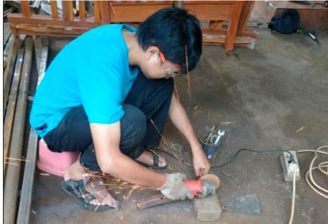
Gambar 3 : Pemotongan besi siku 4x4 inch yang digunakan sebagai kerangka mesin pencacah batang singkong
