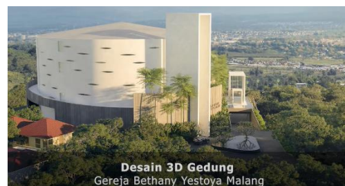
Gambar 4.1 Proyek Gedung Gereja Bethany Yestoya Kota Malang
