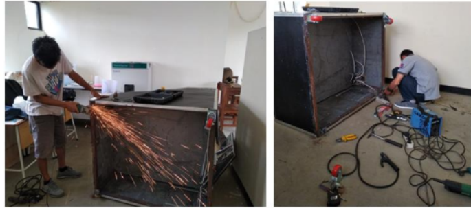
Gambar 5. Pengerjaan perbaikan roda pada alas mesin pengering
