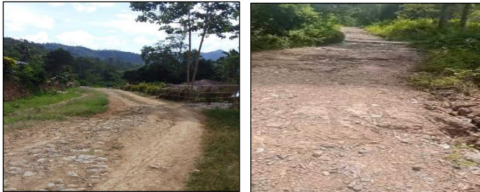
Gambar 1.10 Kondisi Jalan menuju Danau Tiwu Sora
