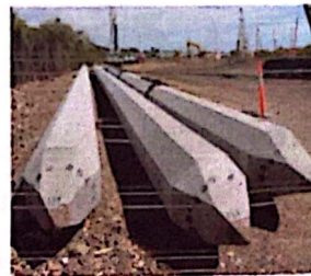
Gambar 2. 15 Contoh gambar fondasi tiang pancang beton pracetak
