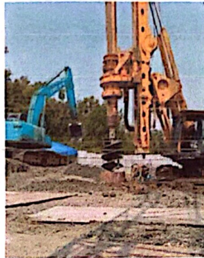
Gambar 2.14 Proses pengeboran tiang bor pada Jembatan di Tol Cipularang KM71
