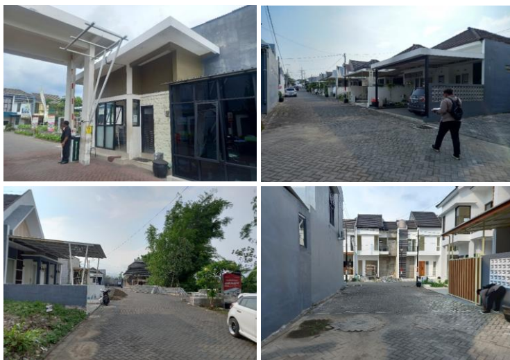
Gambar 1. 1 Gambar Kondisi Perumahan Grand Arumba
