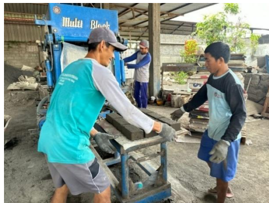
Gambar 1.3 Proses Meletakkan Paving Block Pada Tumpukan Paving Block yang Akan Dikeringkan
