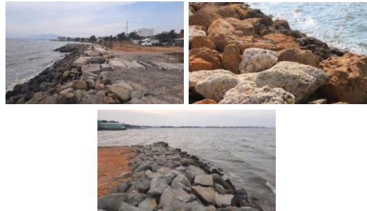
Gambar 4.1 Penahan Abrasi Dengan Batu Kapur
