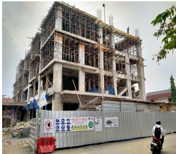
Gambar 1. 1 Pembangunan Proyek Gedung Terpadu FMIPA UGM Yogyakarta
