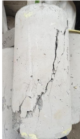
Pola retak silinder beton variasi 2%
