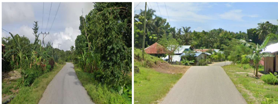
Gambar 1. 2 kondisi di jalan Tana Kaka – Polsek Tanarighu Kabupaten Sumba Barat
