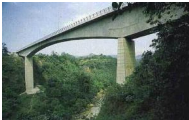
Gambar 1. 1 Kondisi Eksisting Jembatan Rajamandala
